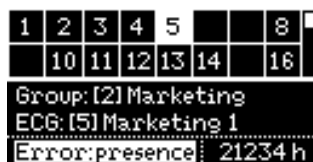
Figure 44. Erreurs du ballast
