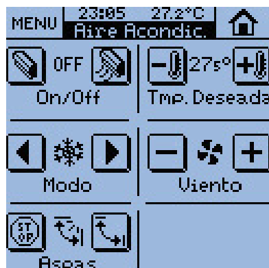
Pantalla de Clima preparada para Aire Acondicionado.
